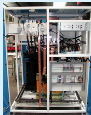
Redresseur pour accélérateur de particules
